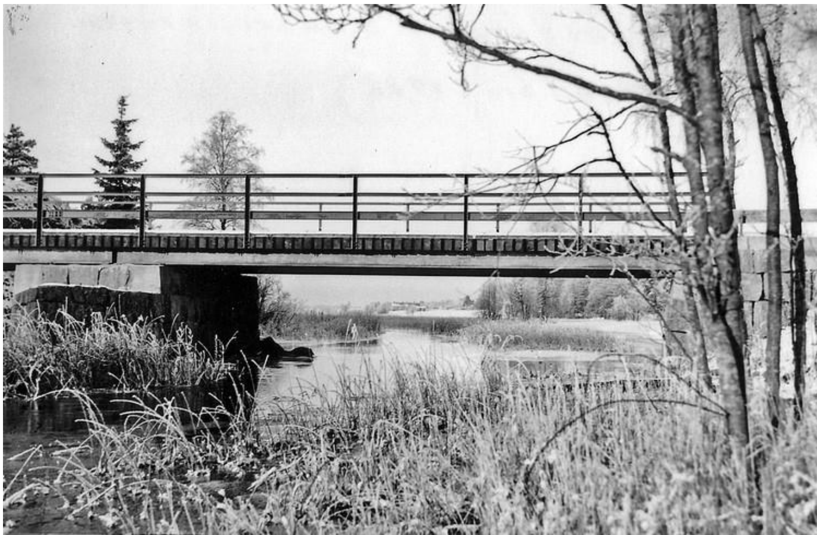
Kvarnkasebron på Uddevallavägen (före nybyggd bro 1988).
