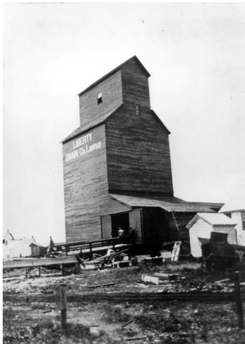
Det byggs torkbyggnad för spannmål i USA. Några av bröderna Dahlgren från Rotenäs nr 17, var med.
