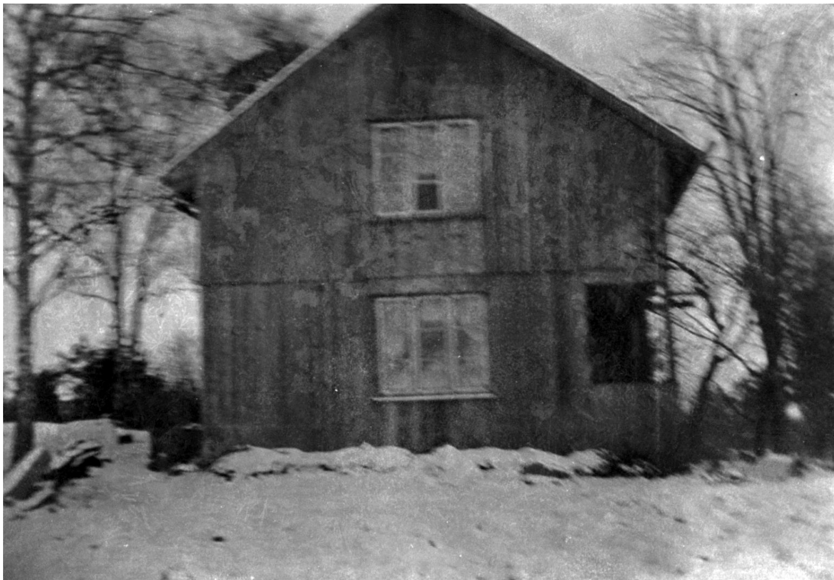
Boningshuset på Öna nr 9, tidigt 1900-tal.
