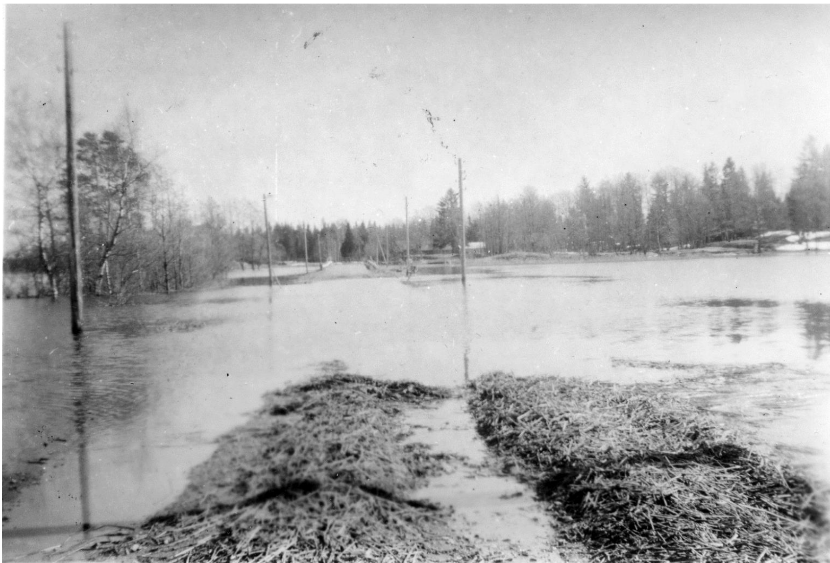
Översvämning på Åbroliavägen mellan Öna nr 13 och Hästefjord nr 1. Telefonledning på vänster sida och kraftledning på höger sida.
