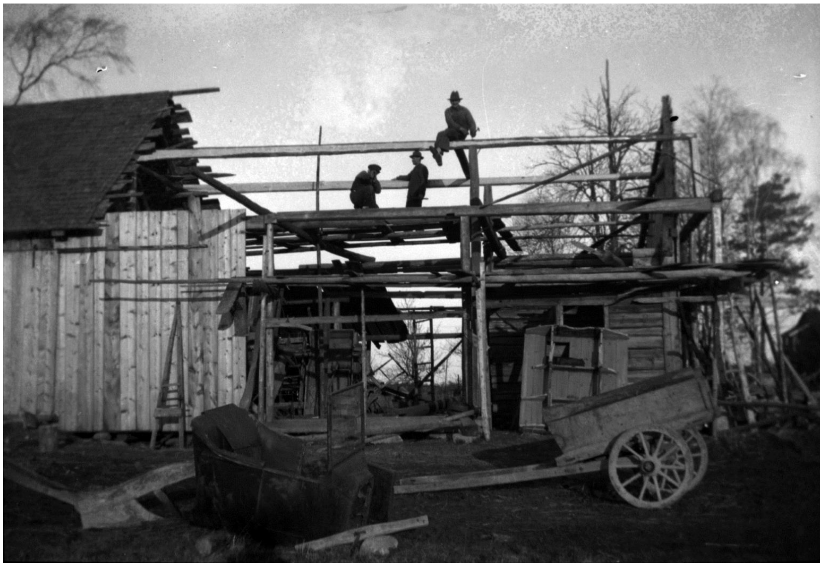
Ladugårdsbygge på Öna nr 9. "Gösselskröv" framför bygget.
