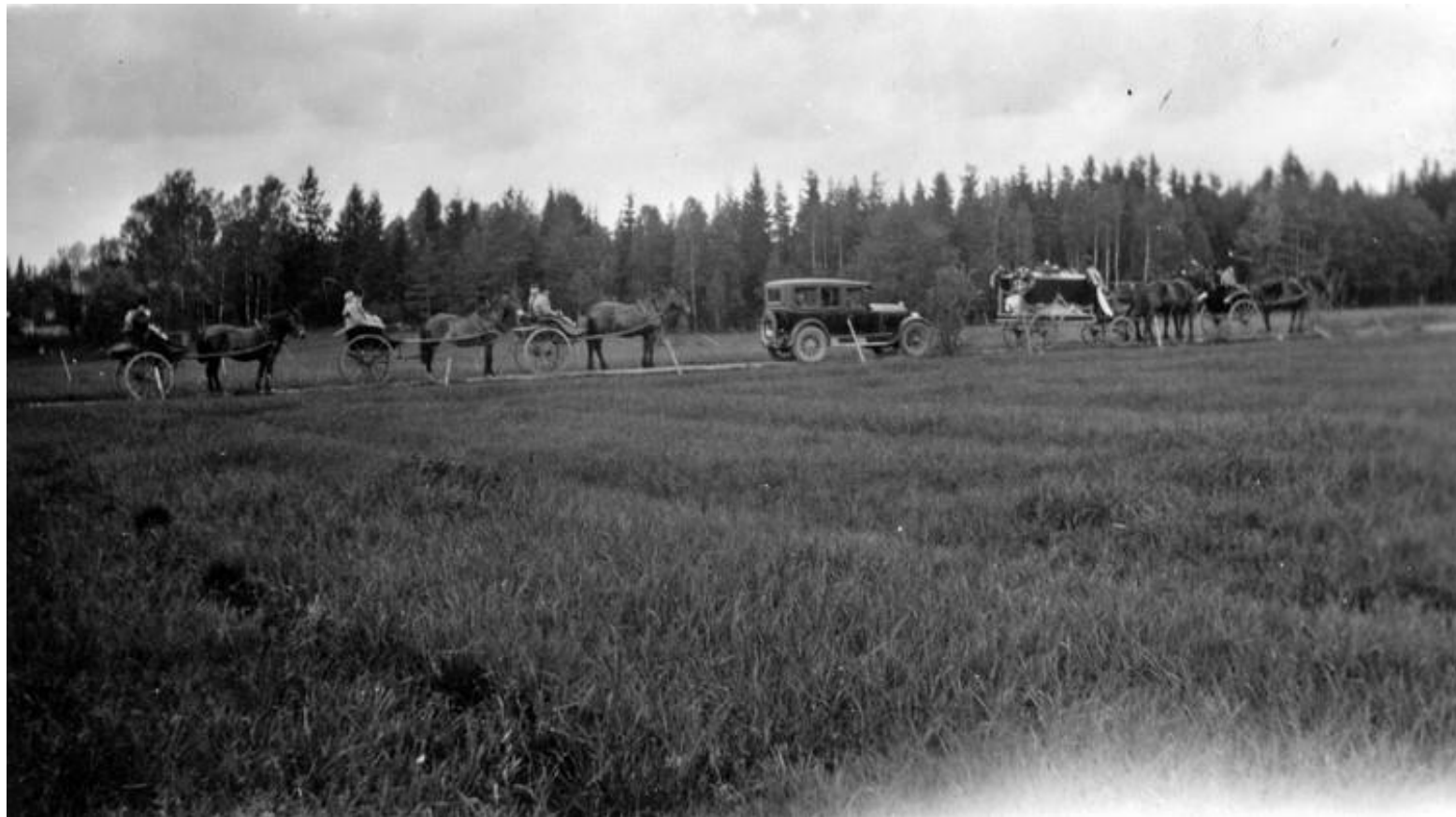
Sofia Anderssons begravning. Binäs nr 2, Änga. Huset längst till vänster i bild är Lugnet.
