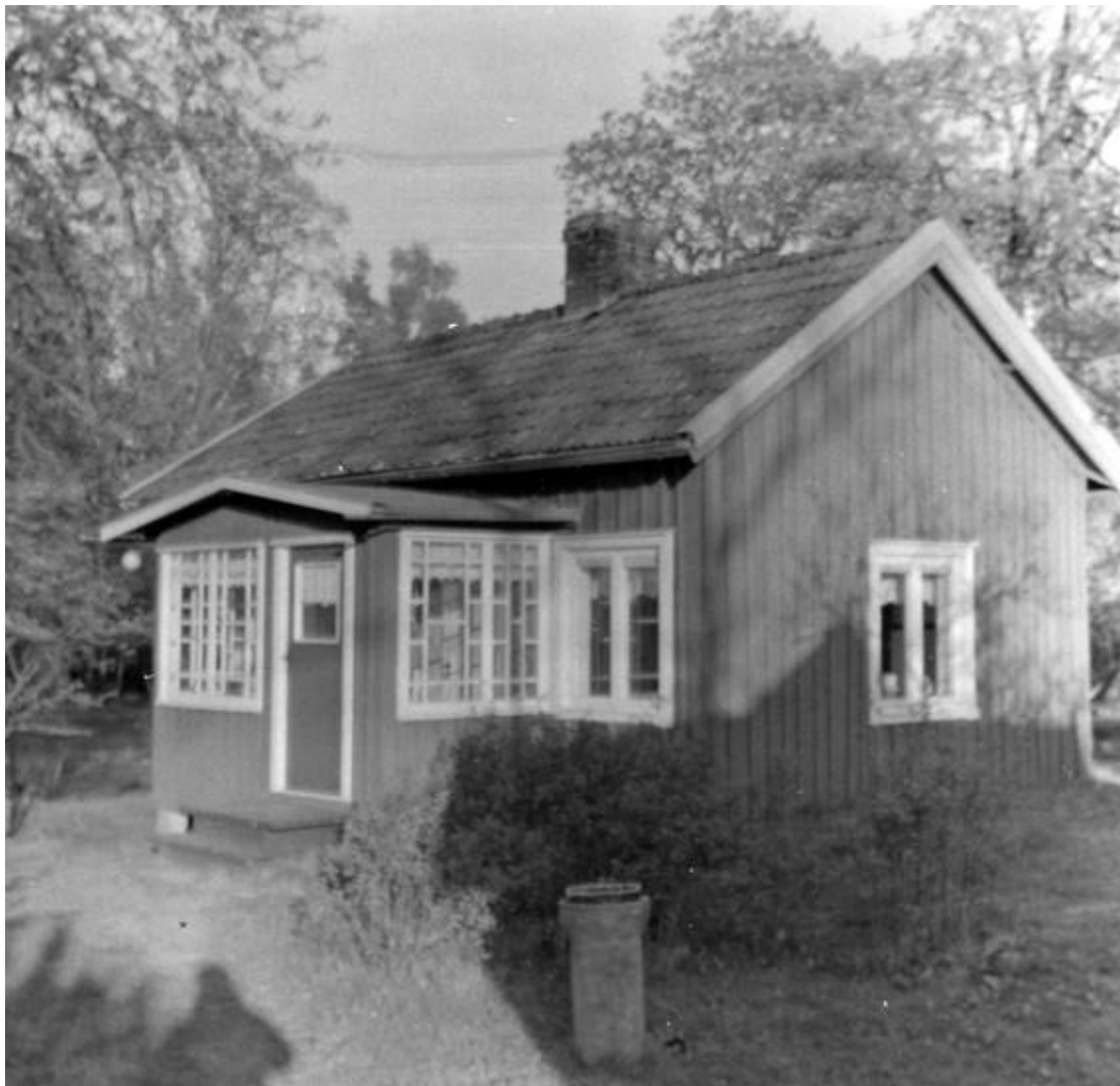
Huset i Binäs nr 21, Bråten, taget 1989.
