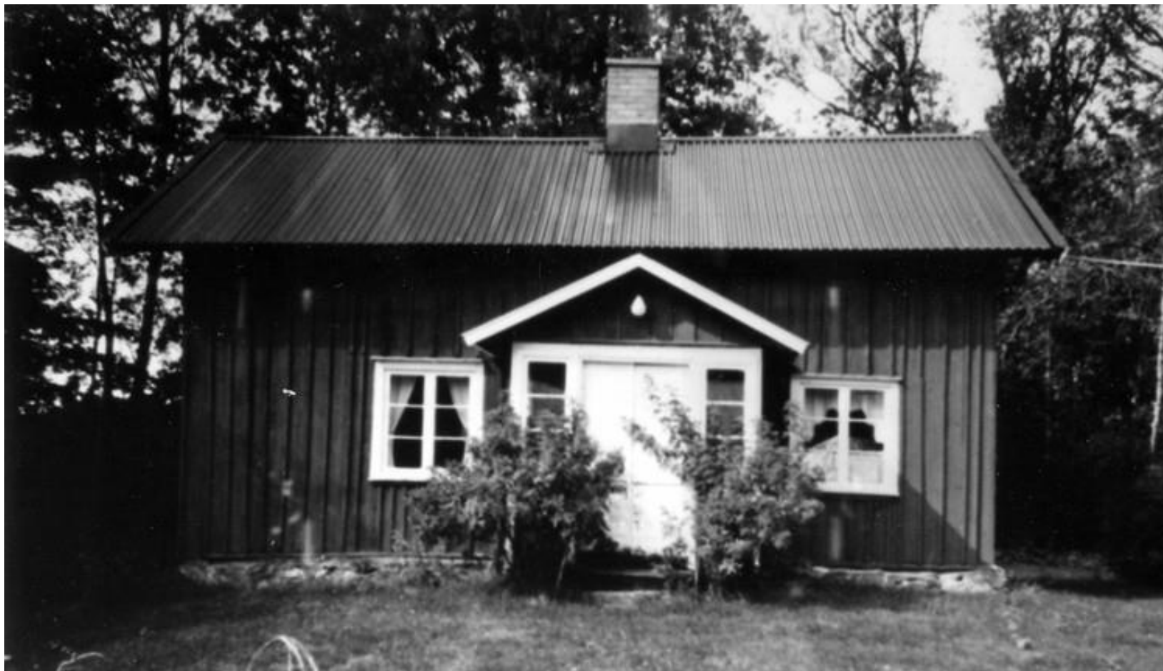
Huset i Binäs nr 18, Gatan.
