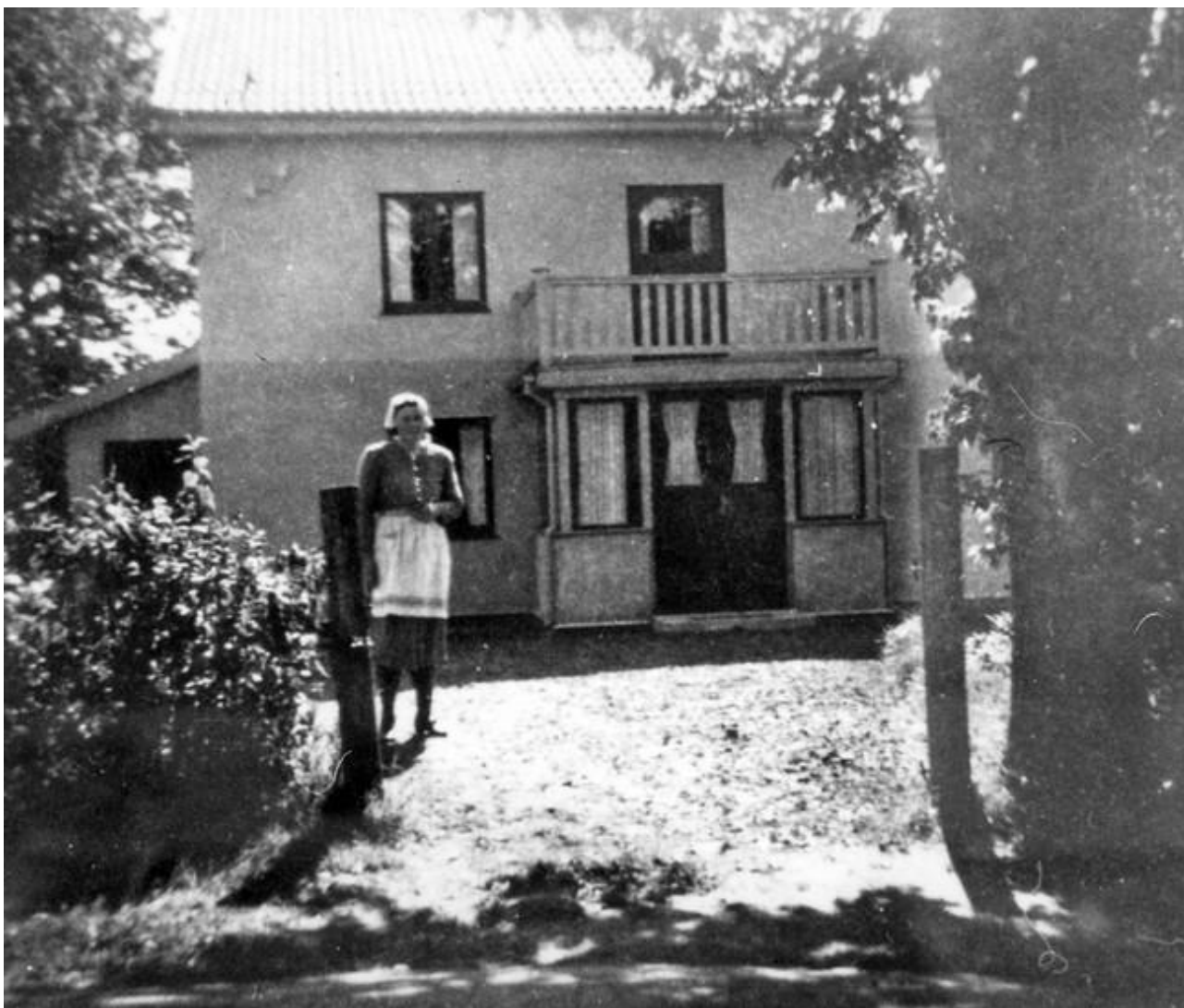
Ellen Deréhn, Binäs nr 5, Nolgårn, framför huset.
